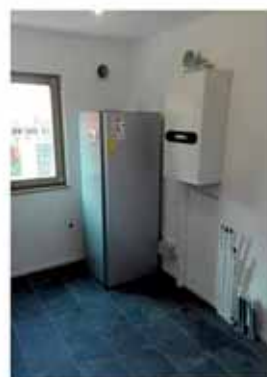
1) Lavori in corso locale caldaia
