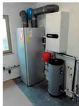
2) Locale caldaia: montaggio e collegamenti avvenuti della pompa di calore per acqua calda sanitaria + riscaldamento + condizionamento abitazione
