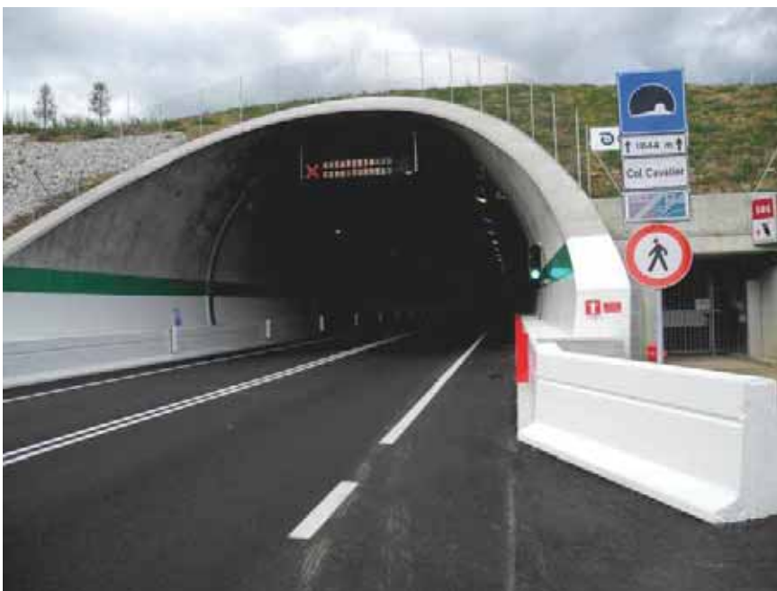
Inbocco della galleria dalla parte di Visome
