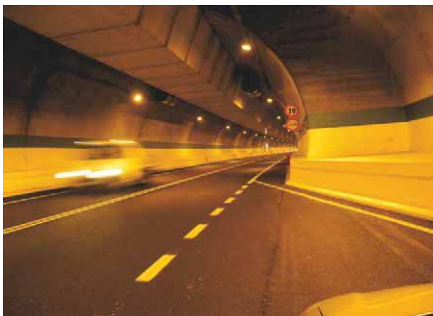
Vista dell'interno con particolare della via di esodo sospesa
